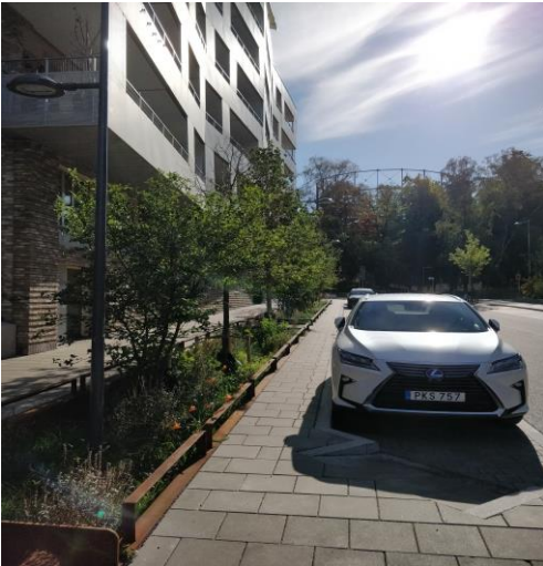
Figur 6-10. Nedsänkt regnbädd vid GC-väg (Foto: Sweco).
