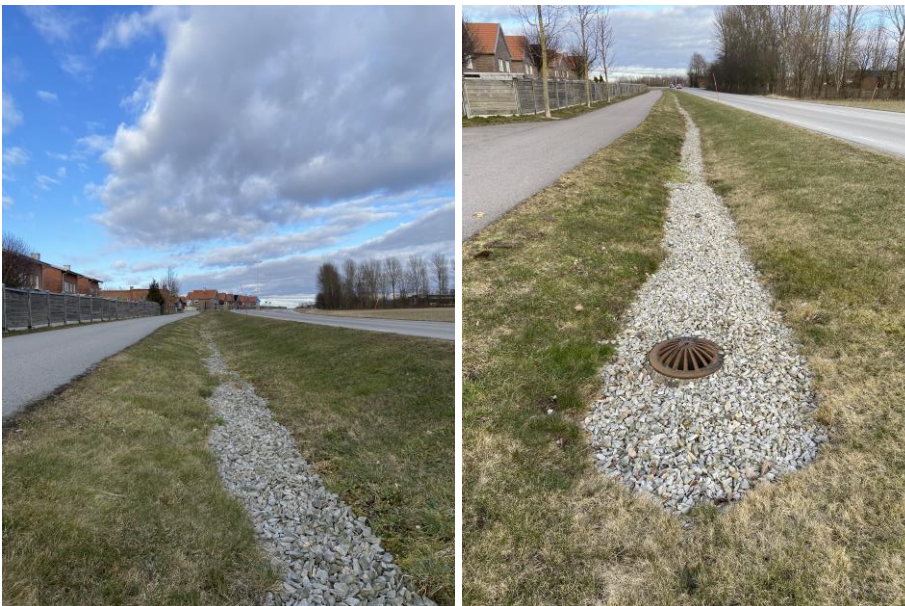
Figur 7-7. Vägdikey – dike med makadam botten, Stångby (Foto: Sweco).
