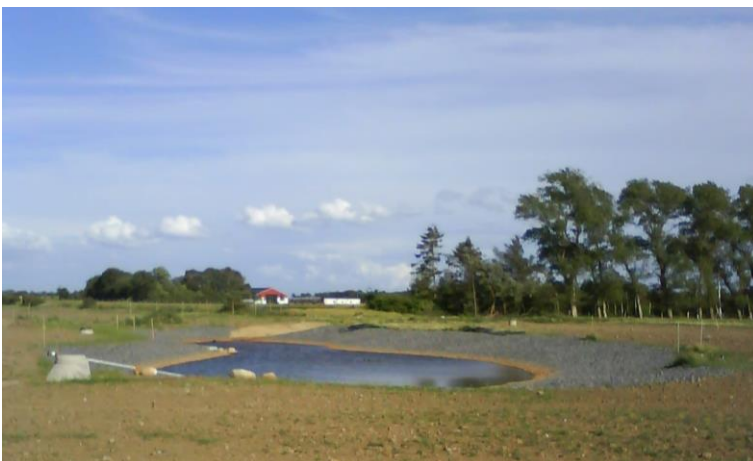
Figur 7-5. Dagvattendamm med vattenspegel, Helsingborg (Foto: Sweco).
