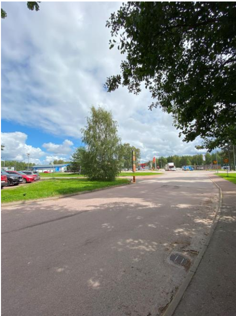
Figur 3-20. Befintlig rännstensbrunn i Bartilsbrovägen i riktning mot befintlig korsning. Motsvarande rännstensbrunn finns på andra sidan vägen (Foto: Sweco).
