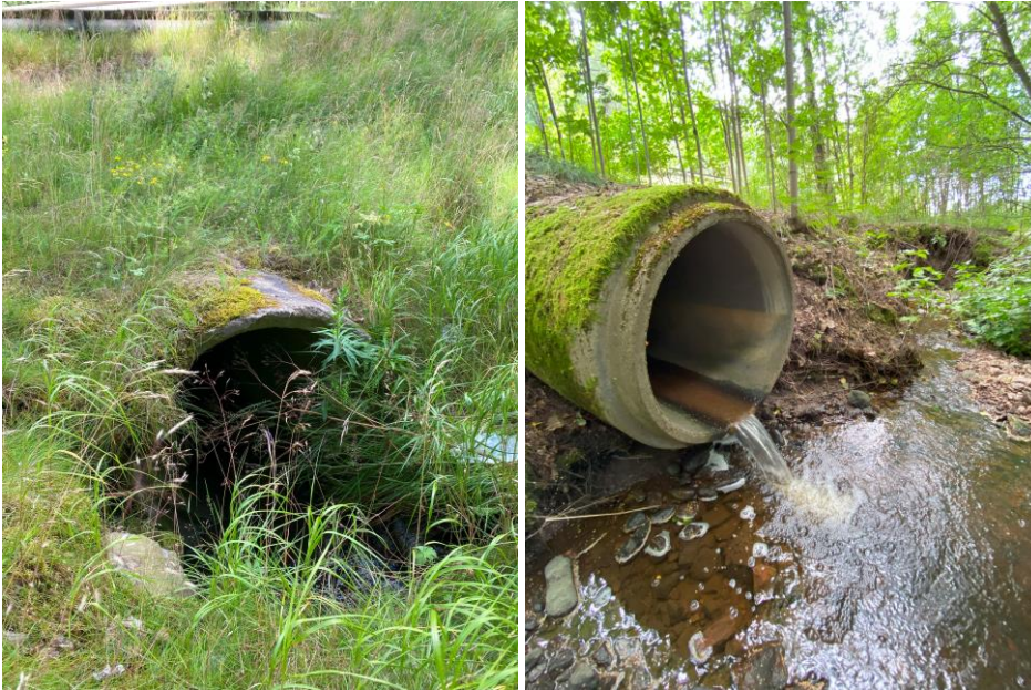
Figur 3-29. Trumma under Väg 26, norr om Vägport 1, som leder vatten från det östra vägdiket till det mindre vattendraget i väster. Höger: inlopp i öster. Vänster: utlopp i öster (Foto: Sweco).
