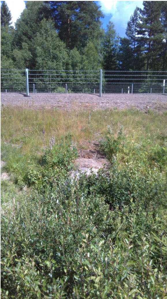
Figur 7-14. BTG1000 under E18. Viss rensning av sly vid inloppet kan krävas (Foto: Kristinehamns kommun, juni 2023).
