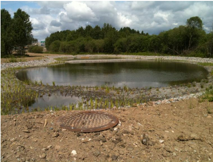
Figur 7-6. Dagvattendamm med vattenspegel längs med E18 (Foto: Sweco).
