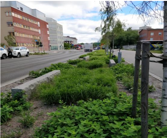
Figur 6-9. Regnbädd vid vägyta (Foto: Sweco).
