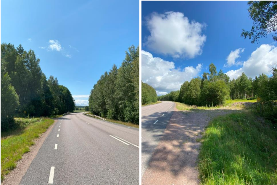
Figur 3-6. Väg 26 vid Delåtgårdsområde 2. Vänster: Väg 26 i södergående riktning. Vägstaket installerat vid vägport under vägen. Höger: Väg 26 i norrgående riktning samt den öppna ytan öster om vägen (Foto: Sweco).
