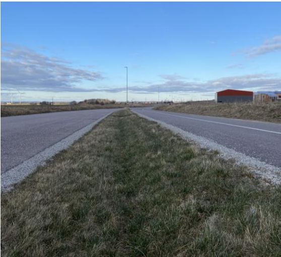
Figur 7-9. Grönt vägdike, Stångby (Foto: Sweco).
