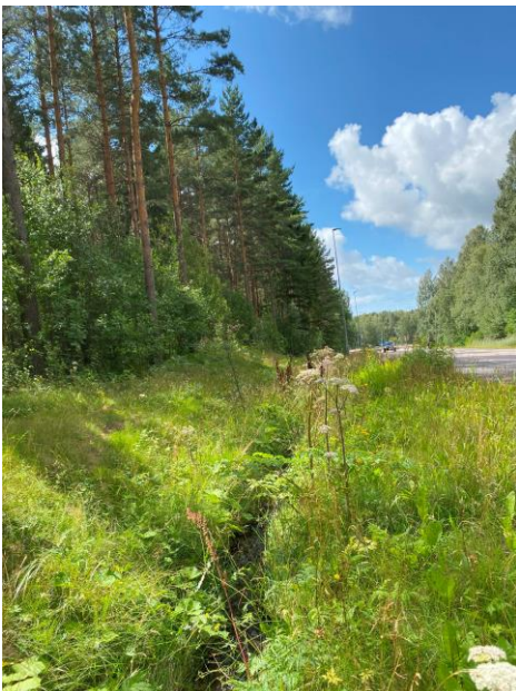
Figur 3-28. Vägdike öster om Väg 26, norr om Vägport 1 (Foto: Sweco).
