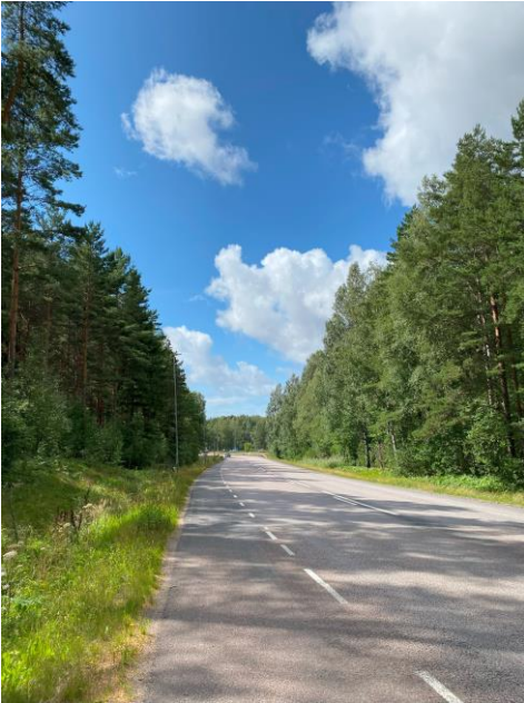
Figur 3-9. Väg 26 i södergående riktning (Foto:Sweco).
