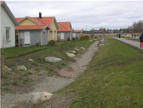
Figur 7-8. Makadamdike, Västerås (Foto: Sweco).
