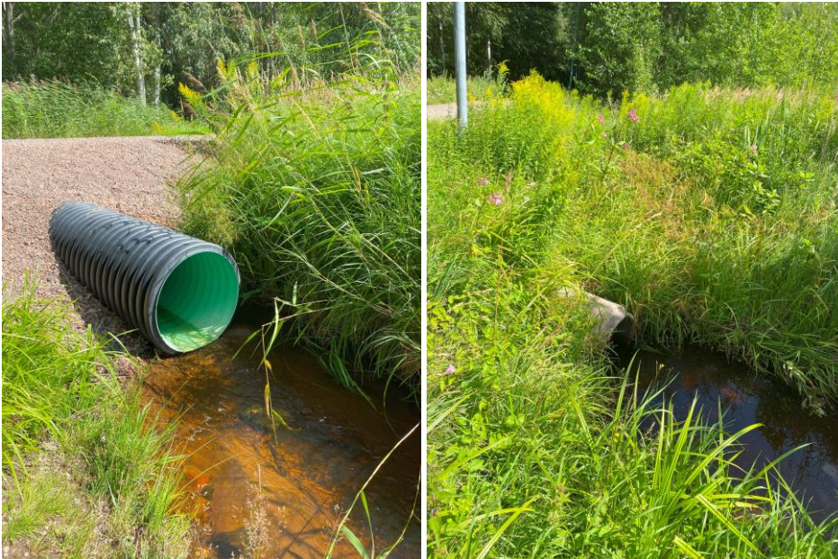
Figur 3-27. Två av de trummor som leder vatten under den befintliga gång- och cykelvägen (Foto: Sweco).
