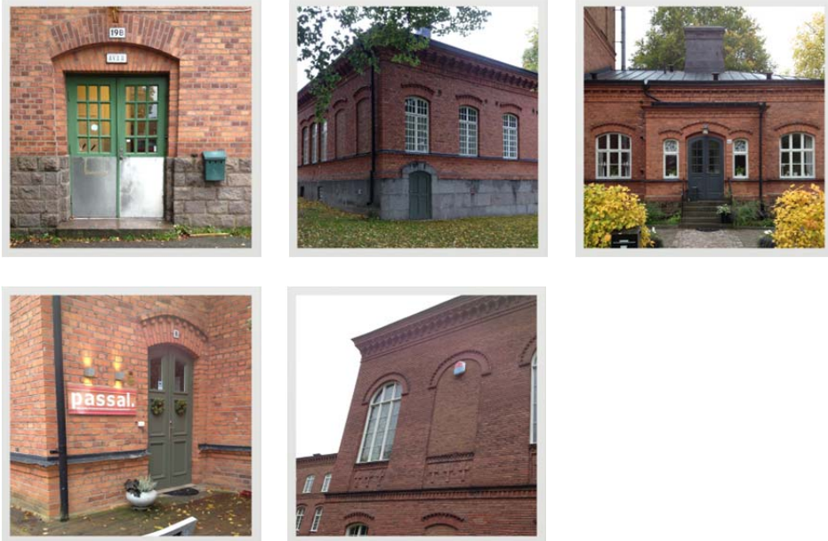
Karaktäristiska dörrar, fönster och plåttak hos området äldre vårdbyggnader.
