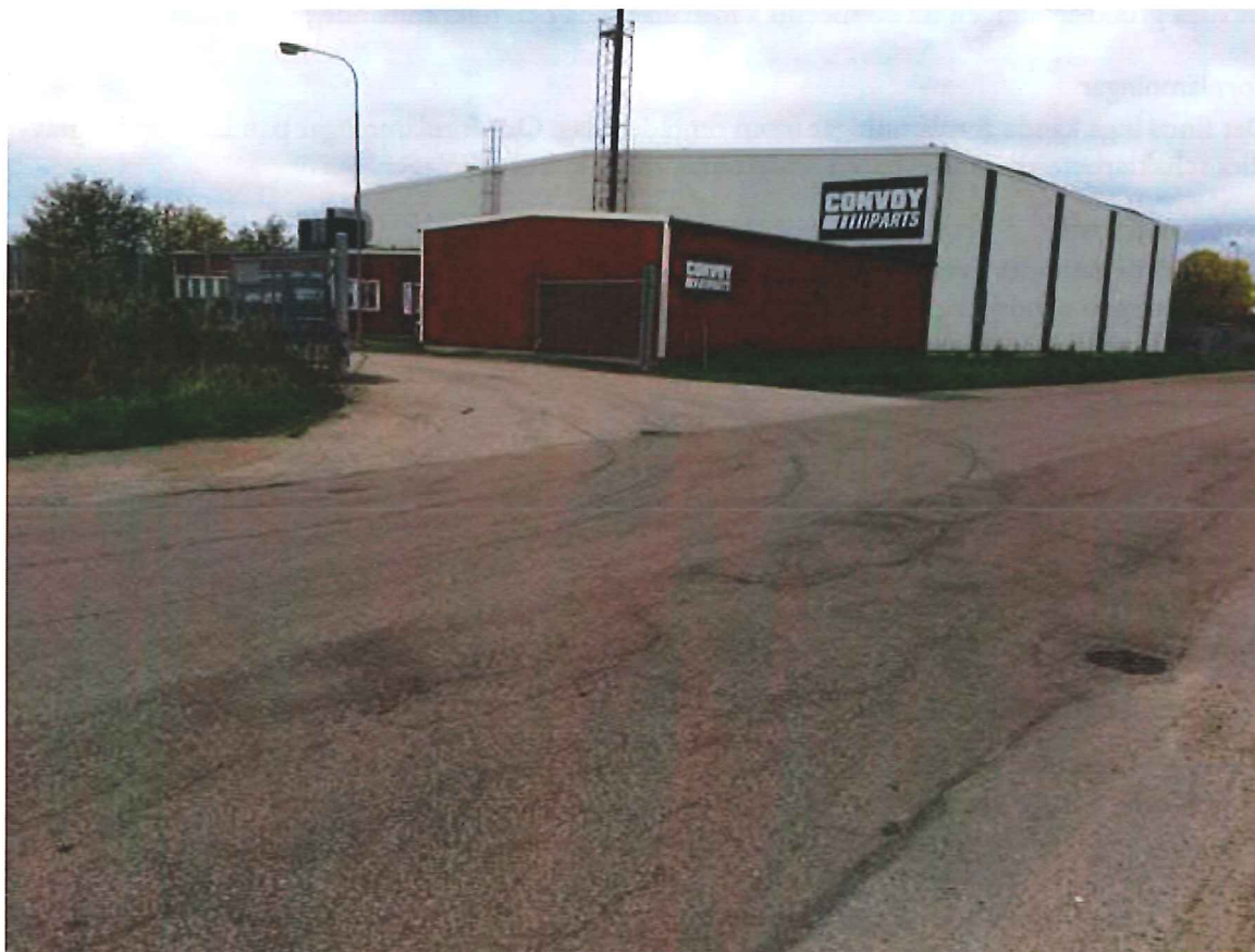
Bild: Industribyggnad på fastigheten Motorn 5.
