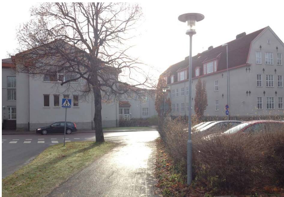
Brogårdsskolan sedd från Prästgatan, byggnadsdelen till höger i bild är kulturhistoriskt värdefull
