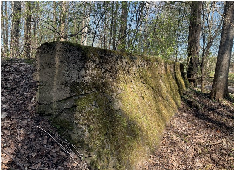
Figur 13. Betongmur vid den registrerade skjutbanan.
