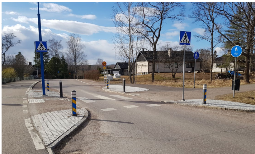
Figur 10. Kort avsmalning av körbanan, här från båda sidor. I Karlstad. Foto: Sweco
