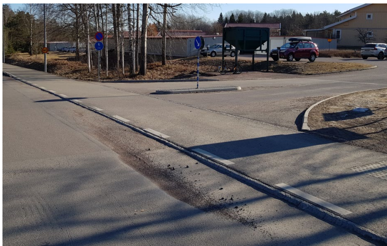
Figur 6. Genomgående gc-bana avgränsad med fasad kantsten respektive nedsänkt kantsten, i Karlstad. Foto: Sweco
