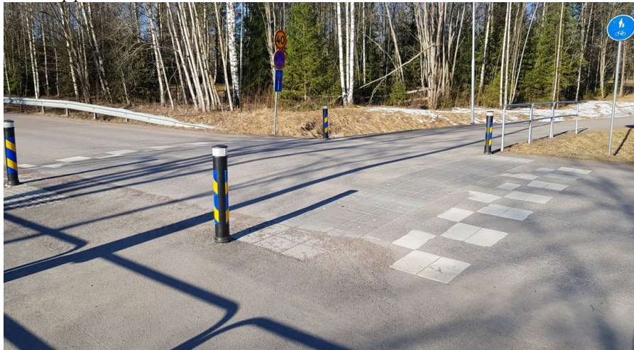
Figur 8. Platågupp vid passage, i Karlstad. Foto: Sweco
