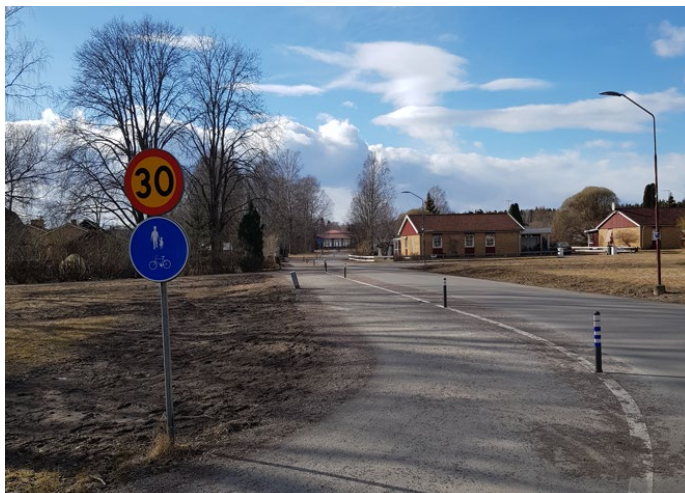
Figur 3. GC-bana avgränsad med vägmarkering och pollare, i Karlstad. Foto: Sweco
