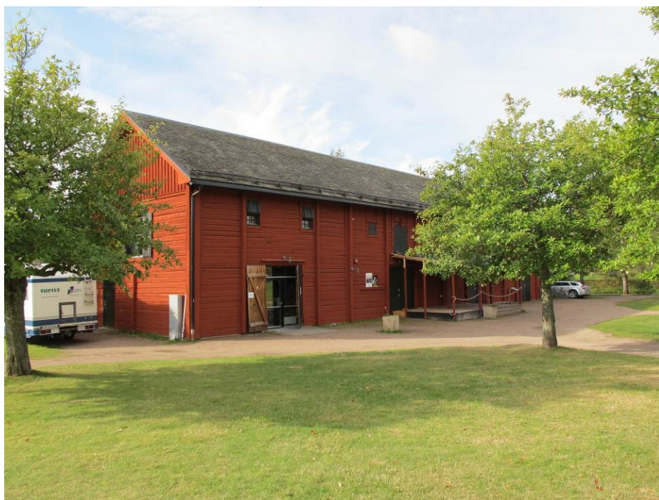
Magasinsbyggnaden som inrymmer Ölme diversehandel och kafé
