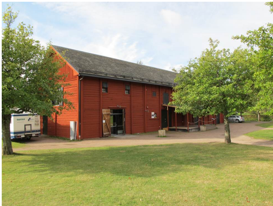
Magasinsbyggnaden som inrymmer Ölme diversehandel och kafé
