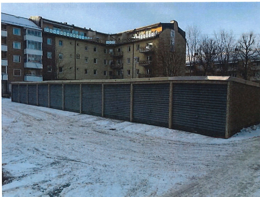
Bild: Befintlig garagelänga.
