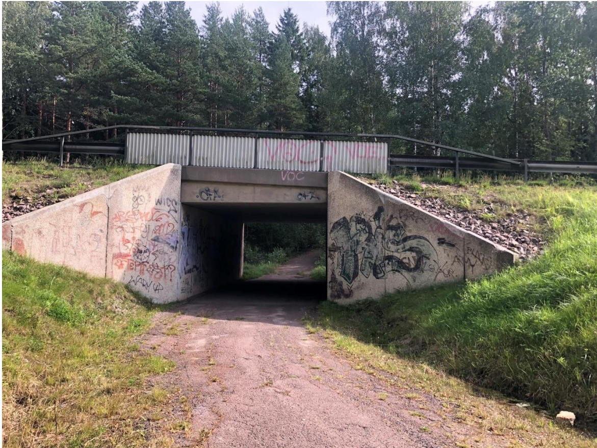
Figur 163 Befintlig gång och cykelbana under väg 26 genom "Norra Porten". Foto: Per Bergström Jonsson, Sweco augusti 2023
