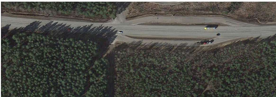
Figur 158 Utfart från "timmervägen" till E18. Timmervägen är den mörka vägen mitt i bilden, Utfart möjlig enbart åt öster, antingen direkt ut i körbanan eller via den södra lastbilsfickan.
