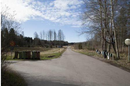
Bilden visar den enskilda vägen Hjälmarsnäs vägen som är typisk för standarden för de lite större enskilda vägarna i området.
