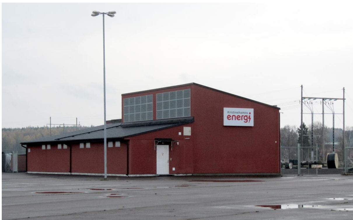
Bild: Ställverks- och transformatorbyggnaden
