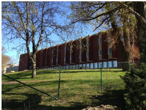
Foto: Vårdbyggnaden för rättspsykiatri norra fasad.
