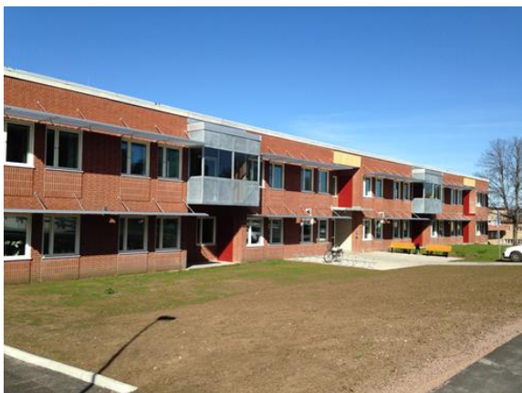
Foto: Vårdbyggnaden för rättspsykiatri södra fasad.
