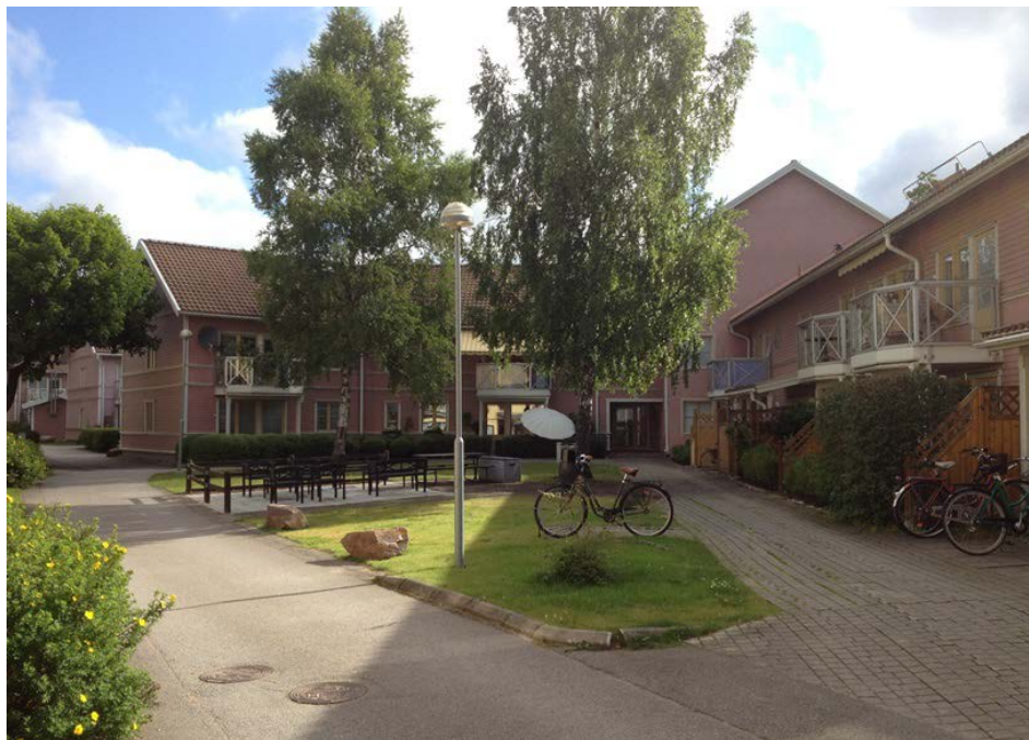
Bostadsbebyggelse på fastigheten Älgen 10
