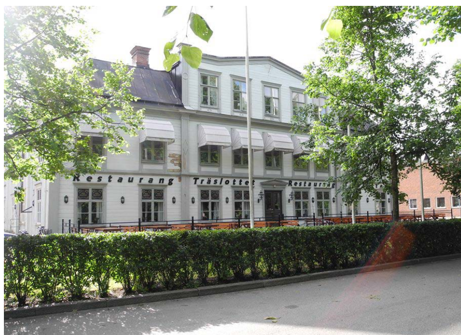
Kontorsbyggnaden väster om planområdet
